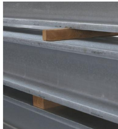
Фото 4. Деревянные вставки для обеспечения необходимой вентиляции.
